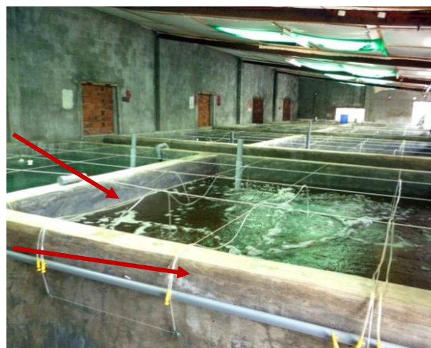
Hình 1.6.7: Bố trí ống dẫn khí trong trại
